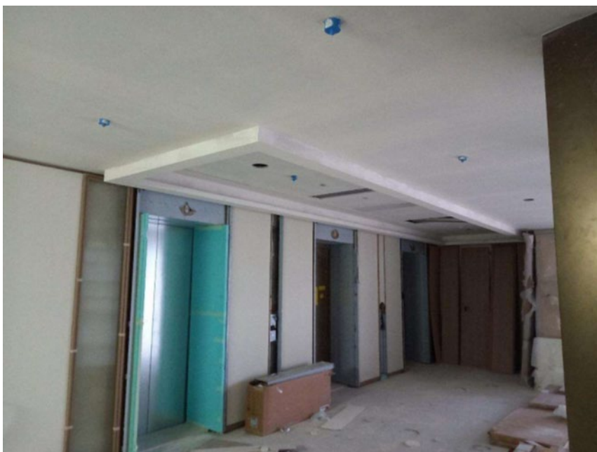
Εικόνα 5-3 Διάδρομος 4ου Ορόφου στην είσοδο των Ασανσέρ
