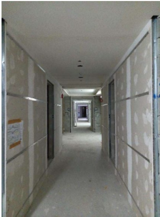
Εικόνα 5-2 Διάδρομος 4ου ορόφου
