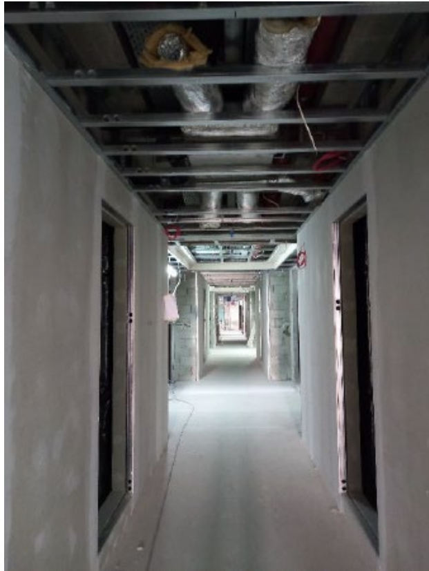
Εικόνα 5-10 Διάδρομος 5ου ορόφου
