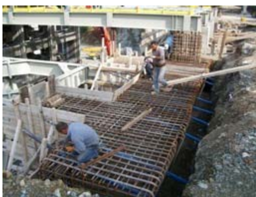
Εικόνα 5: Εργασίες για την κατασκευή κτιρίου
