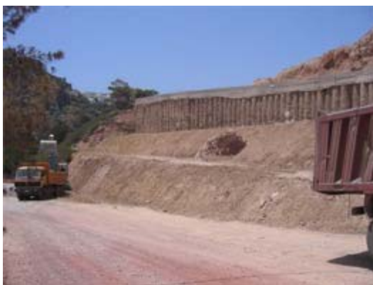
Εικόνα 4: Εργασίες εκσκαφής για την κατασκευή δρόμου
