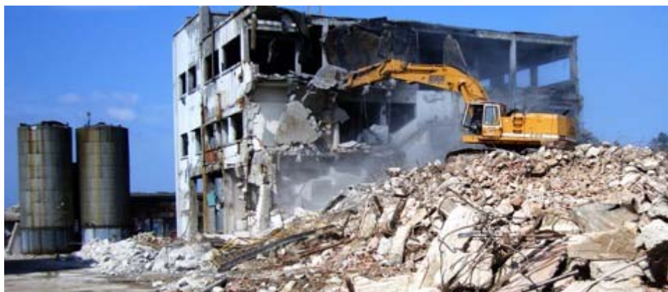
Εικόνα 2: Εργασίες κατεδάφισης οικοδομής με υδραυλικό εκσκαφέα
