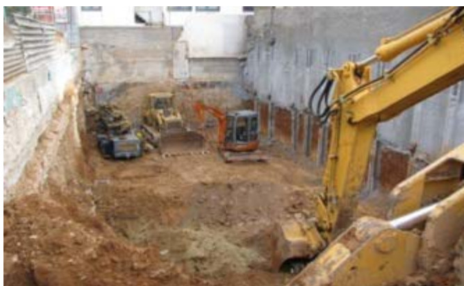
Εικόνα 3: Εργασίες εκσκαφής υπόγειου χώρου οικοδομής
