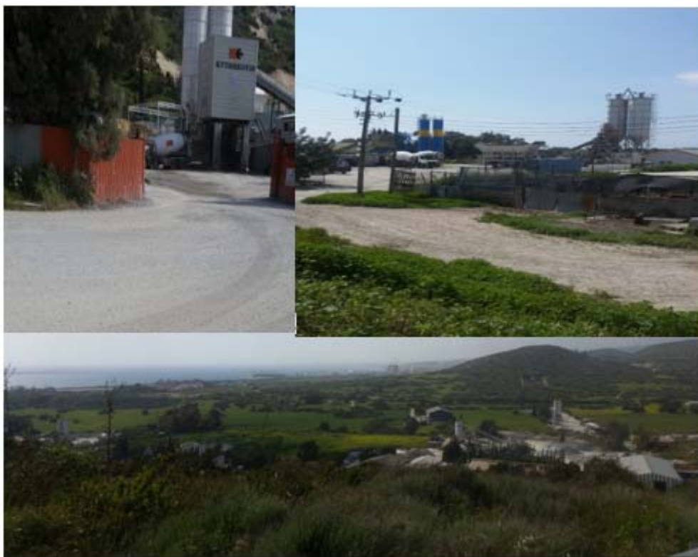
ΕΙΚΟΝΑ 3.1: Τσιμεντοποιείο στη περιοχή της Μονής
