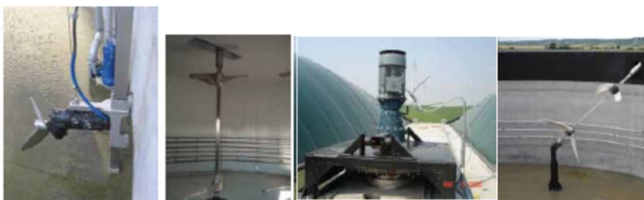
Εικόνα 3.10 Αναδευτήρας έλικας με καταδύόμενο μοτέρ και αναδευτήρες κρεμασμένων πτερυγίων (αριστερά) και η αντίστοιχη μηχανή ανάδευσης (AGRINZ 2006)
