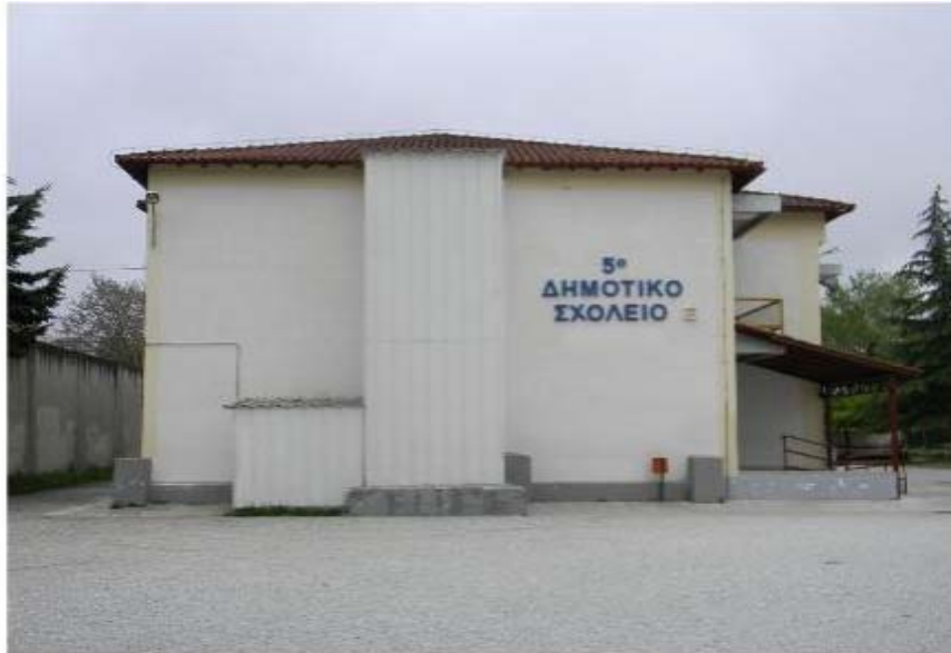
Εικόνα 2: Ανατολική όψη του 5 ου Δημοτικού Σχολείου Σερρών
