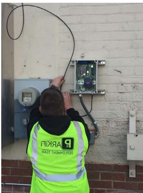
Εικ. 8: Τοποθέτηση δέκτη δεδομένων προερχόμενα από τους αισθητήρες (Parkifi.com, 2017)
