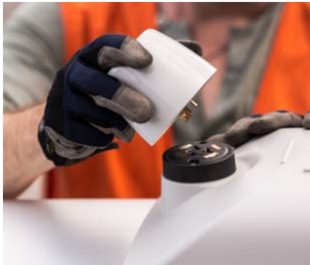
Εικ. 5: Εγκατάσταση CityTouch κόμβων σε υφιστάμενους πασσάλους φωτισμού (Philips, 2015)
