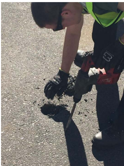
Εικ. 9: Τοποθέτηση αισθητήρων (Parkifi.com, 2017)
