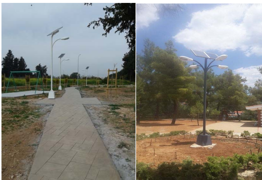
Figure 8: Αυτόνομα συστήματα Φωταγώγησης (Φ.Β Πυλώνες Φωτισμού)
