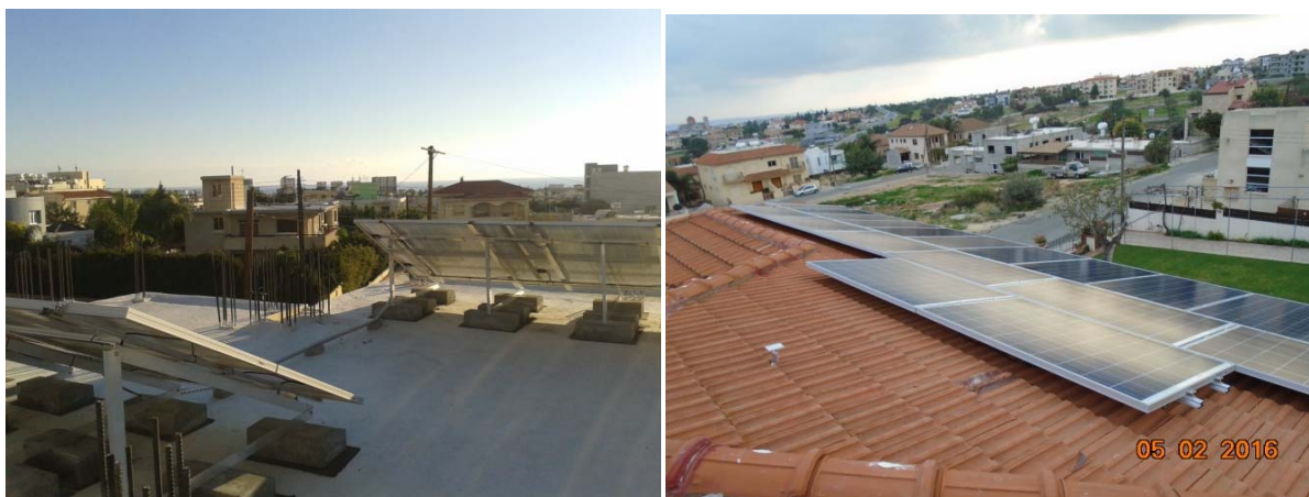
Figure 21: Ορθή πρακτική εγκατάσταση Φ.Β σε επίπεδη οροφή και κεραμοσκεπή
