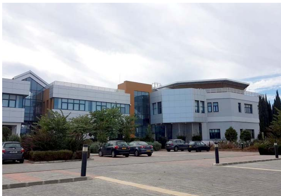
Φωτογραφία 2: Το νέο κτίριο του Κέντρου Ελέγχου στην Κοκκινοτριμιθιά 35
