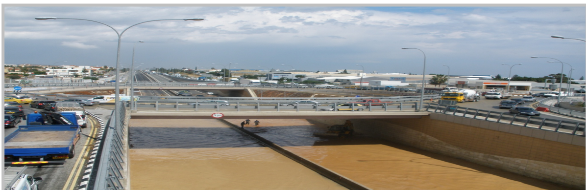
Εικόνα 8.1 Αποτέλεσμα πλημμυρικού φαινομένου- Υπερχειλίση αποχετευτικού συστήματος
