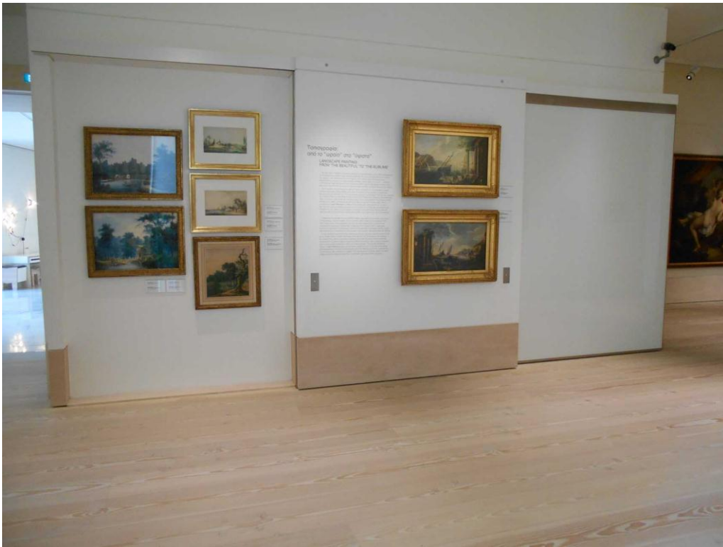
Εικ. 10 Ηλεκτρονική πόρτα προστασίας εκθεμάτων (ανοιχτή)
