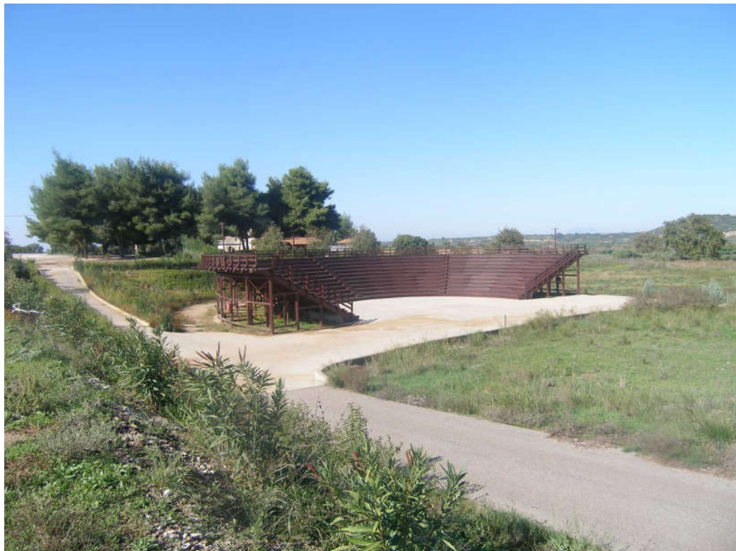
Εικ. 9. Λυόμενο θέατρο Ήλιδος στο οποίο πραγματοποιούνται εκδηλώσεις. (Μουρτζίνη, 2015)
