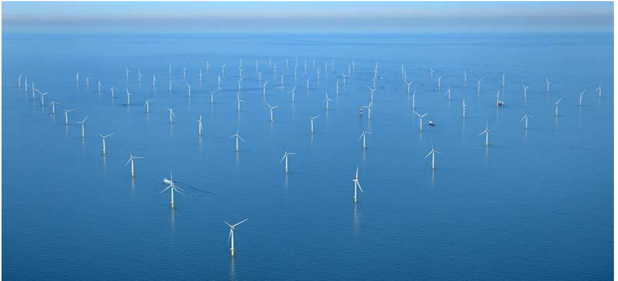
Εικόνα 2.16: Υπεράκτιο Αιολικό Πάρκο (Πηγή: www.elsevier.com )
