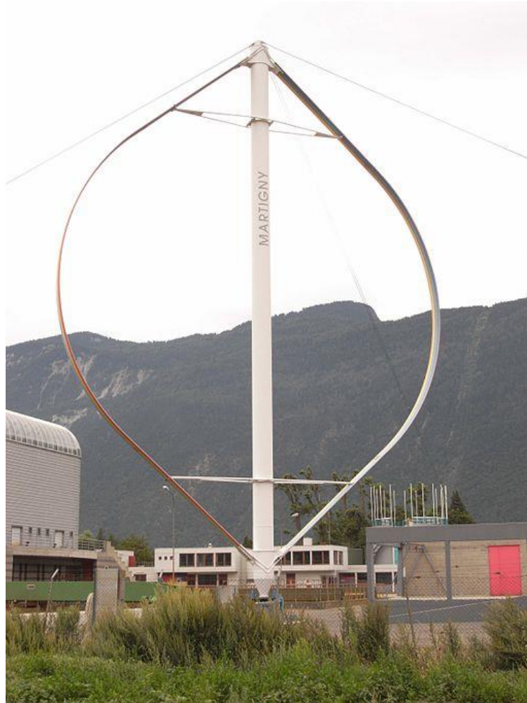
Εικόνα 2.12: Ανεμογεννήτρια Κατακόρυφου Άξονα τύπου Darrieus (Πηγή: www.eia.gov )
