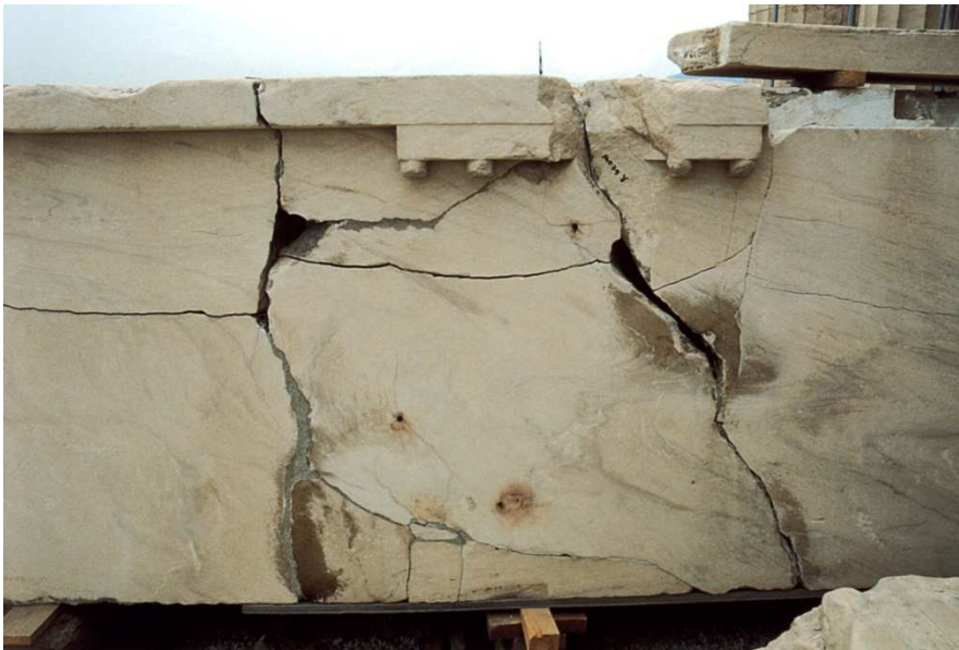
Εικόνα Ε.2.1 Ακρόπολη οι σιδερένιοι σύνδεσμοι τίναξαν το μάρμαρο
