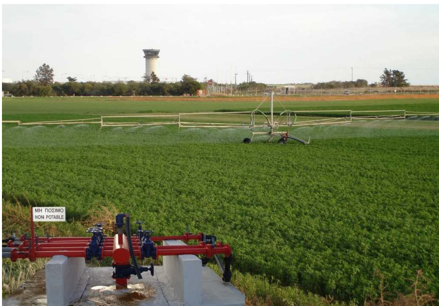
Εικόνα 2.2. Άρδευση με ανακυκλωμένο νερό (εξαρτήματα και σωλήνες με κατάλληλη σήμανση) (Συμβούλιο αποχετεύσεων Λεμεσού, 2016).
