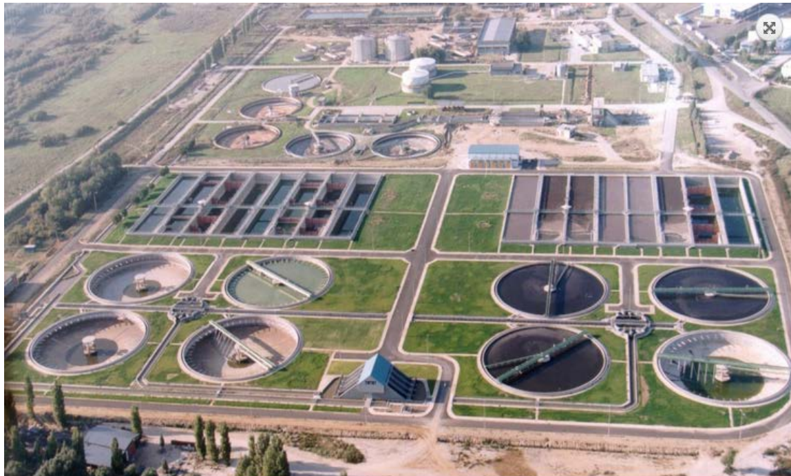
Εικ. 2.6 Εγκατάσταση Επεξεργασίας Λυμάτων Θεσσαλονίκη
