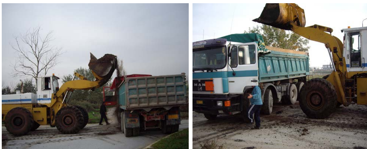
Εικόνα 2.3. Μεταφόρτωση ιλύος σε φορτηγά.
