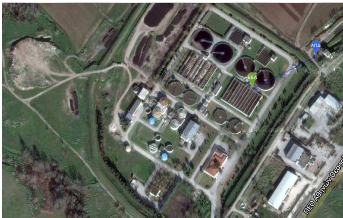
Εικ. 2.7 Εγκατάσταση Επεξεργασίας Λυμάτων Λάρισας
