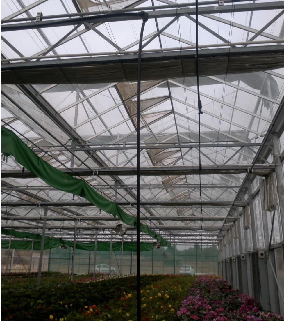
Εικόνα 29: Φωτογραφία από το εσωτερικό του θερμοκηπίου στο οποίο φαίνεται η παραγωγή αλλά και η οροφή του
