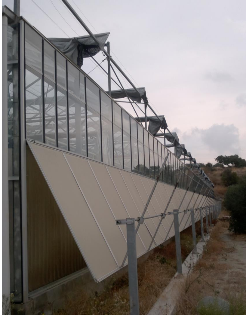
Εικόνα 38: Φωτογραφία εξωτερικά του θερμοκηπίου στην οποία φαίνονται τα πλάγια ηλεκτρικά σκέπαστρα
