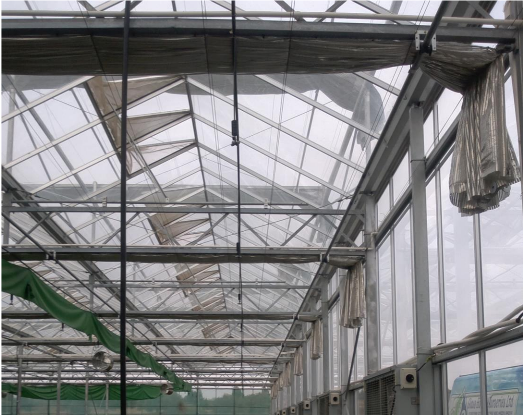
Εικόνα 34: Φωτογραφία από το εσωτερικό του θερμοκηπίου στην οποία φαίνονται οι εσωτερικές κουρτίνες που χρησιμοποιούνται για την σκίαση των φυτών
