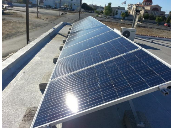
Εικόνα 22: Φωτοβολταϊκό σύστημα 3 kWp σε οριζόντια στέγη σε οικία στα Λατσιά Λευκωσίας, Gesolar Cyprus Ltd 2014
