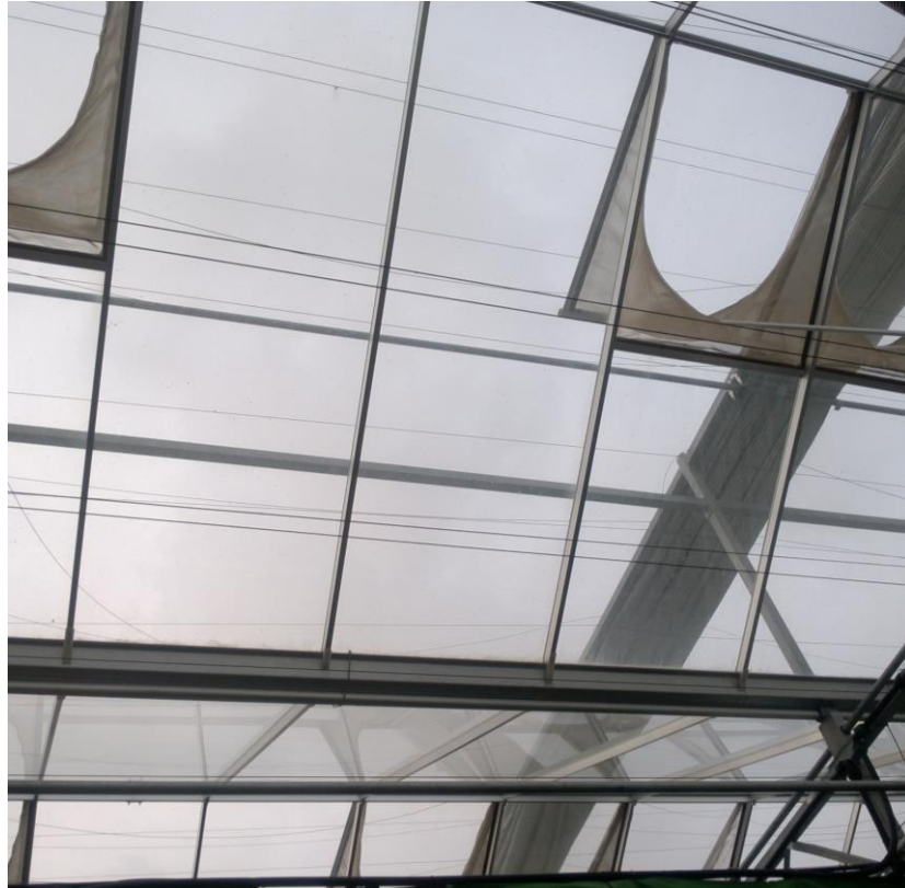
Εικόνα 32: Φωτογραφία στην οποία φαίνονται τα ηλεκτρικά ανοιγόμενα παράθυρα που βρίσκονται στην οροφή του θερμοκηπίου
