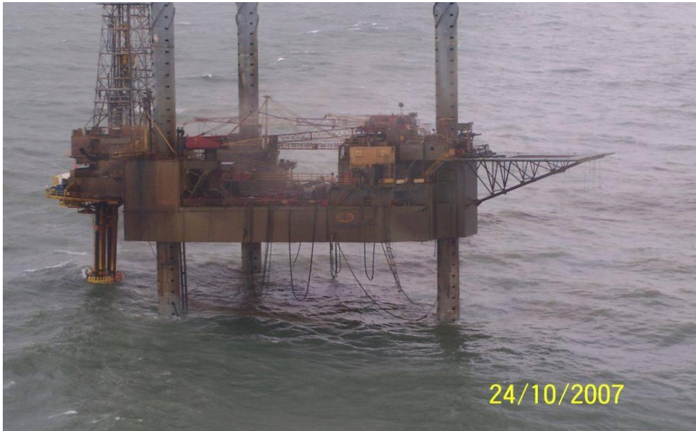
Εικόνα 1.14.1.1. : Η πλατφόρμα Kab 101 και η πλατφόρμα Usumacinta Platform μια μέρα μετά την έκρηξη.
