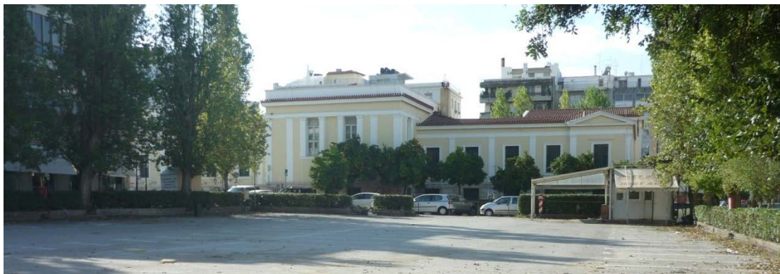
Εικόνα 5.6 Το παρκινγκ (χώρος στάθμευσης αυτοκινήτων και η είσοδος σε αυτό
