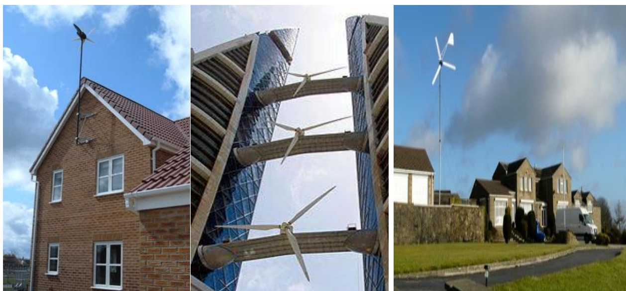
Εικόνα 3.64 Τοποθέτηση Α/Γ και ενσωμάτωση σε κτήριο.
