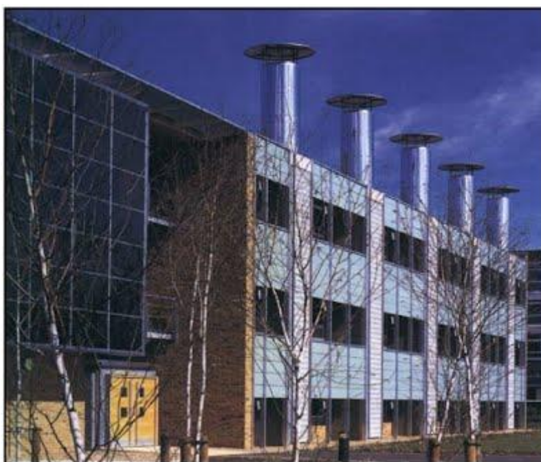
Εικόνα 3.37 Ηλιακές καμινάδες στο Building Research Establishment, Watford, United Kingdom (Jones, D. L, 1996)
