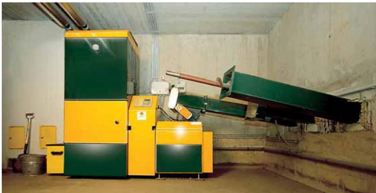
Εικόνα 3.65 Διάταξη λέβητα στερεού καυσίμου (Πηγή: ΤΕΕ-ΔΕ4, 2011).
