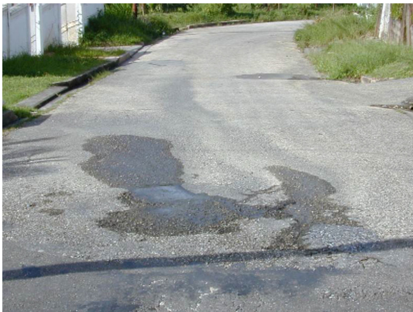
Εικόνα 3.2: διαρροή ορατή στο οδόστρωμα
