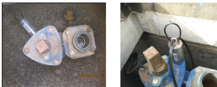
Εικόνα 4.4: τοποθέτηση καταγραφών-αισθητήρων
