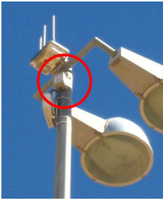
Εικόνα 4.5: εγκατάσταση αναμεταδότη
