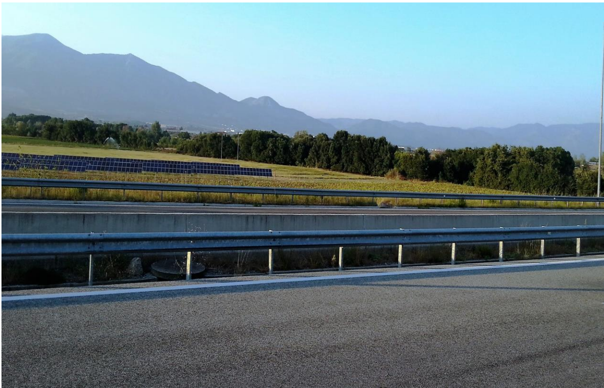
Εικόνα 44. Φωτοβολταϊκά εκατέρωθεν της Εγνατίας οδού στο νομό Ξάνθης.
