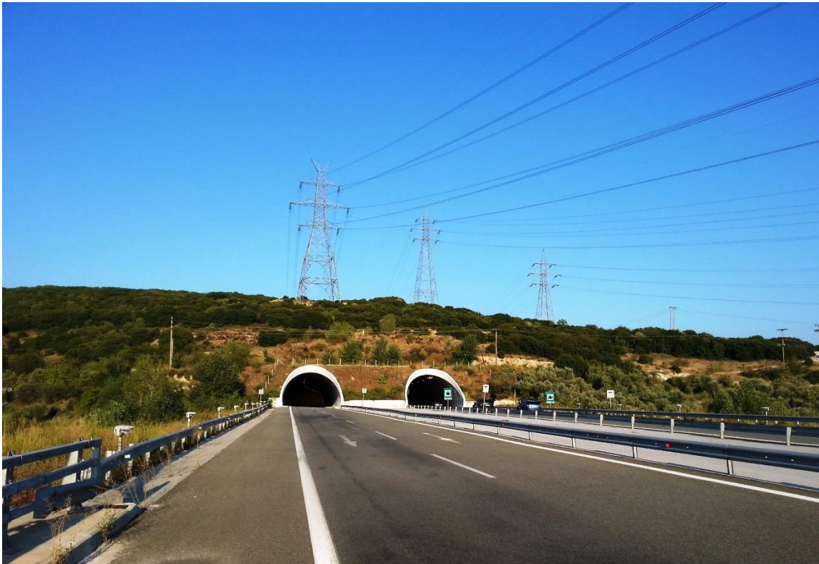
Εικόνα 30. Εγνατία οδός - Δίδυμη σήραγγα (Ν. Ξάνθης).
