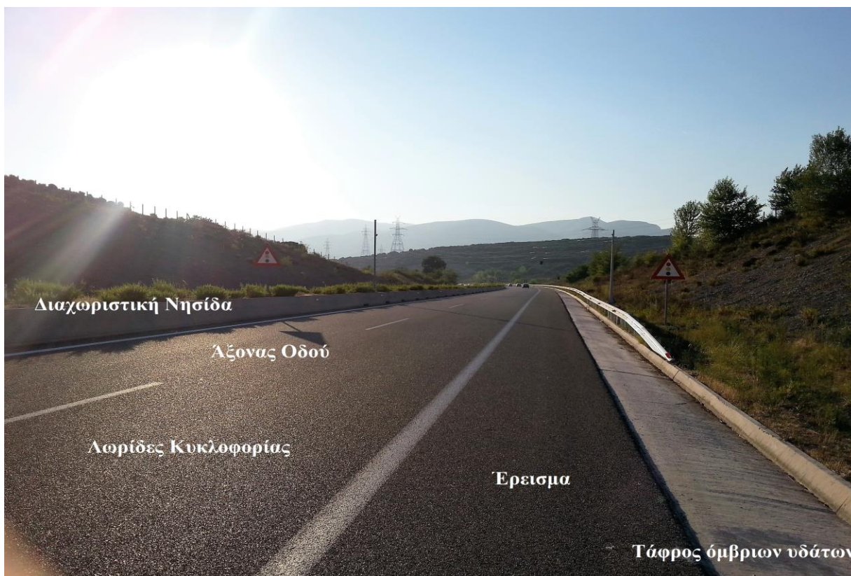
Εικόνα 35. Διαχωριστική νησίδα–Λωρίδες κυκλοφορίας–Έρεισμα Εγνατίας οδού (Ν. Ξάνθης)
