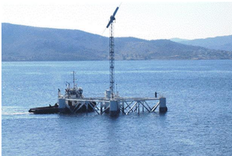
Εικόνα 1.9: Πλωτός μηχανισμός αφαλάτωσης «Υδριάδα» της Νάξου, ( http://www.kykladiki.gr )
