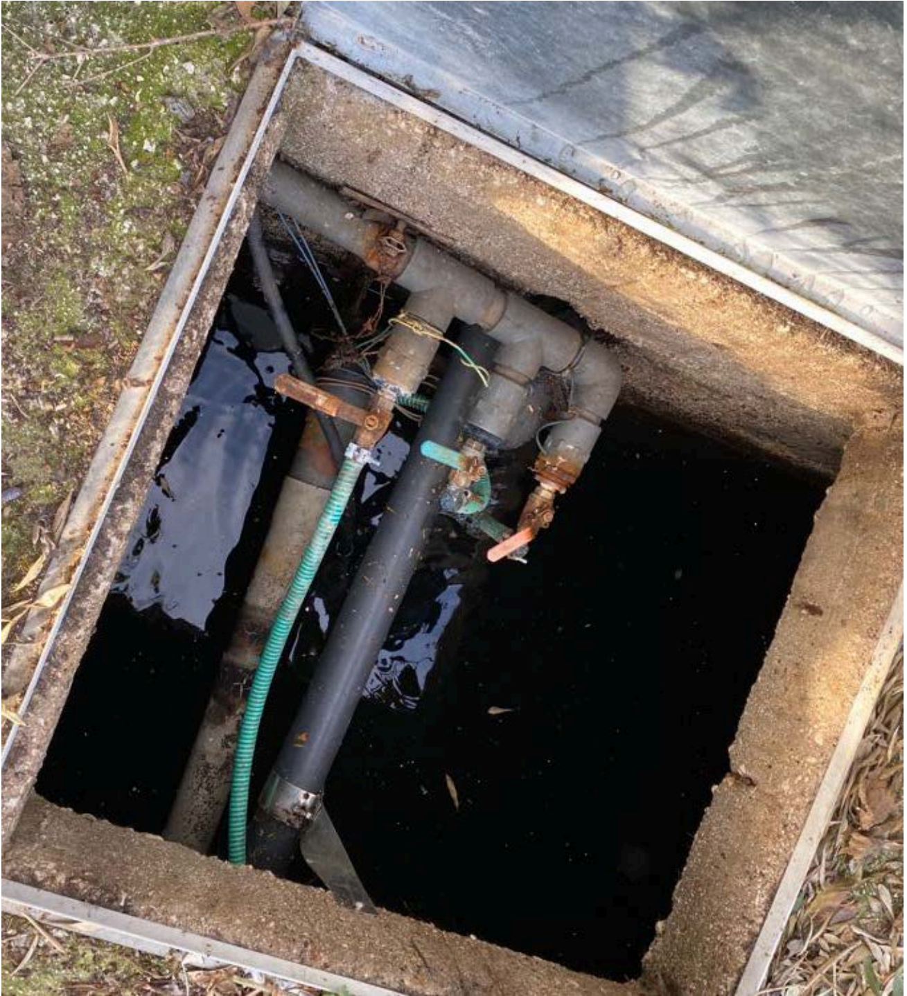
Εικόνα 28: Δεξαμενή χλωρίωσης
