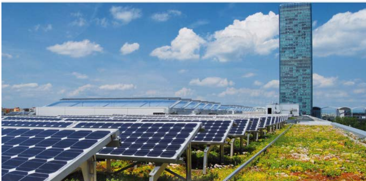
Εικόνα 44: Συνδυαστική χρήση ΦΒ συστημάτων και πράσινης στέγης ( https://www.egreen.gr/ ).
