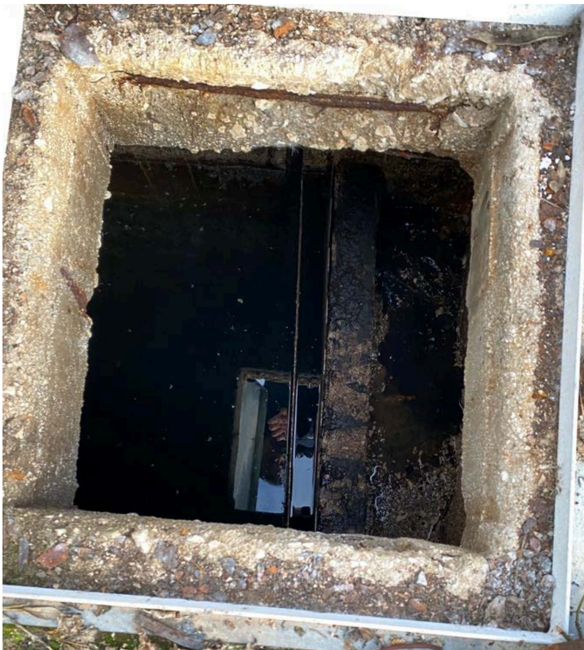
Εικόνα 27: Εγκατάσταση εσχάρωσης βιολογικού καθαρισμού.
