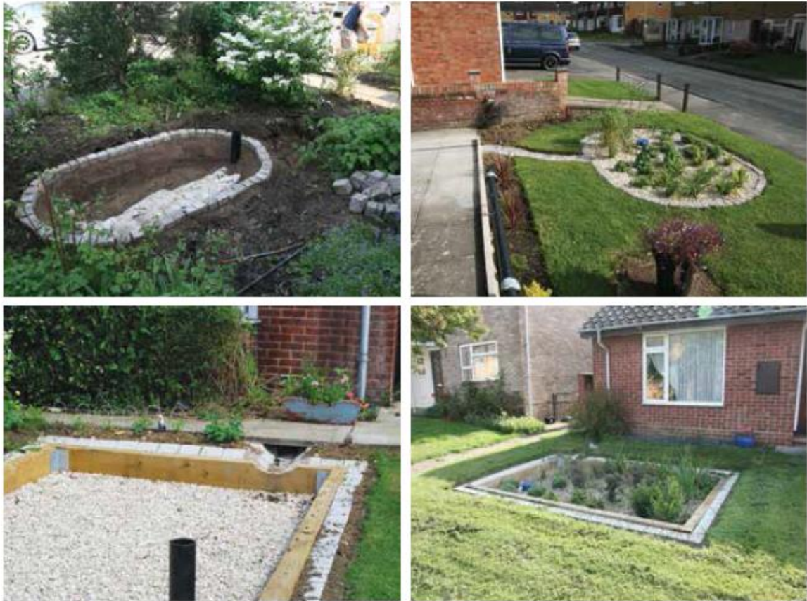
Εικόνα 4.43: Παραδείγματα κήπων βροχής κατά την κατασκευή (αριστερά) και στην τελική τους μορφή (δεξιά). Πηγή (Kellagher et al. 2015).
