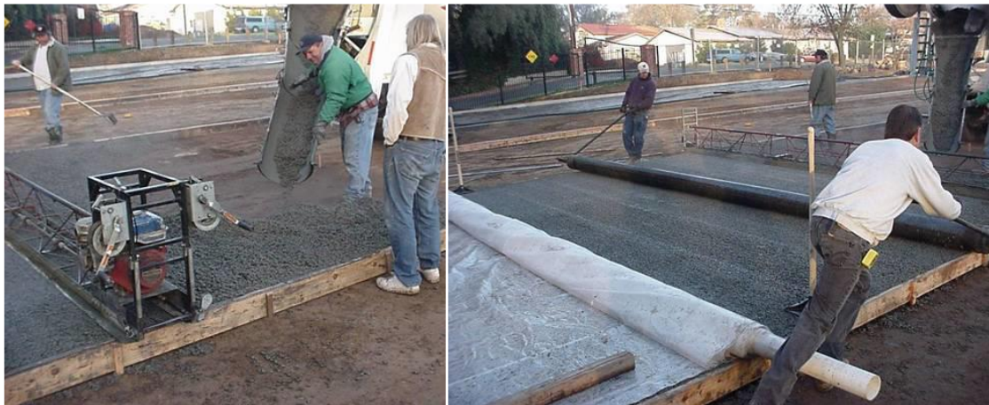
Εικόνα 4.20: Κατασκευή δαπέδου από διαπερατό σκυρόδεμα (Kevern et al. 2006).
