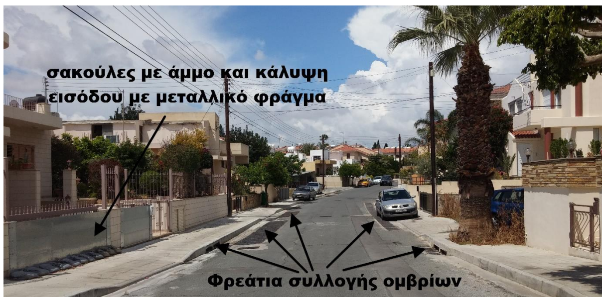
Εικόνα 2.3: Παράδειγμα από την περιοχή μελέτης. Επειδή συγκεντρώνεται νερό στη συγκεκριμένη οδό, έχουν κατασκευαστεί τεράστιες σχάρες για τη συλλογή των ομβρίων.
