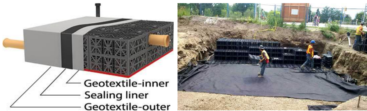
Εικόνα 5.9: Κατασκευή συστήματος Graf EcoBloc Light Modular Water Storage System. Πηγή (RainHarvest Systems 2016).
