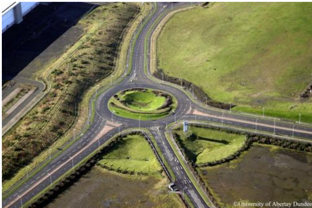
Εικόνα 5.34: Λίμνη κατακράτησης σε κυκλικό κόμβο. Πηγή (Sudsdrain 2012a)
