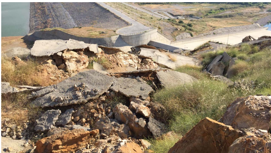
Εικόνα 10. Όψη της κατολισθαίνουσας μάζας (Γεω. Περ. Σύμβουλοι Μηχανικοί Α.Ε., 2017)
