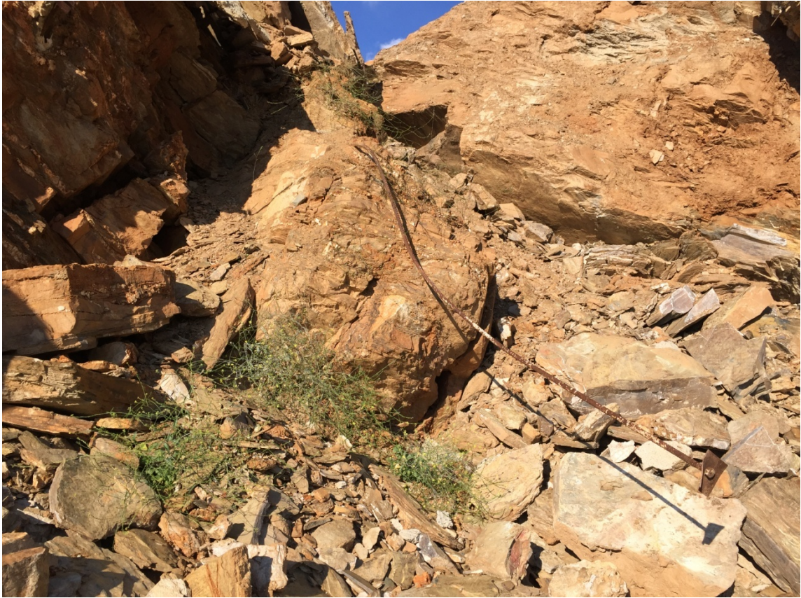
Εικόνα 11. Αποκάλυψη των αγκυρίων που είχαν τοποθετηθεί στο πρανές (Γεω. Περ. Σύμβουλοι Μηχανικοί Α.Ε., 2017)
