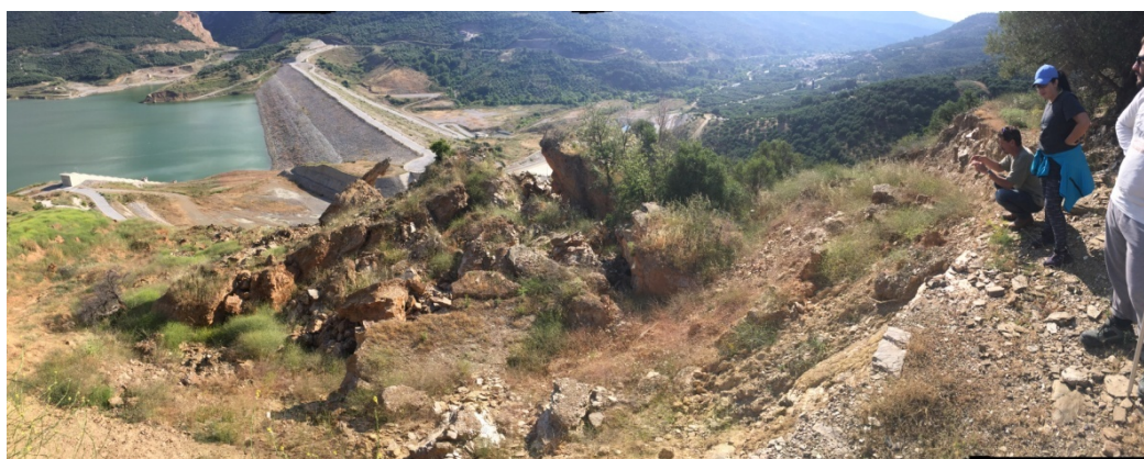
Εικόνα 8. Όψη της κατολίσθησης (Γεω. Περ. Σύμβουλοι Μηχανικοί Α.Ε., 2017)
