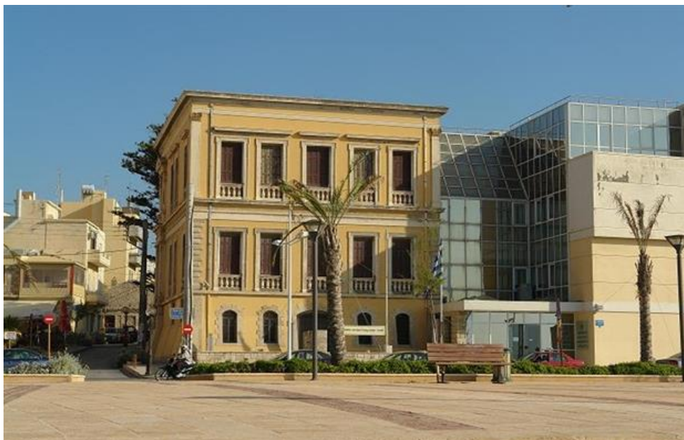
Εικόνα 6. Πρόσοψη του κτιρίου
