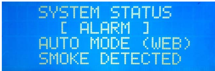
Εικόνα 3.19: Ένδειξη display για περίπτωση εντοπισμού καπνού
