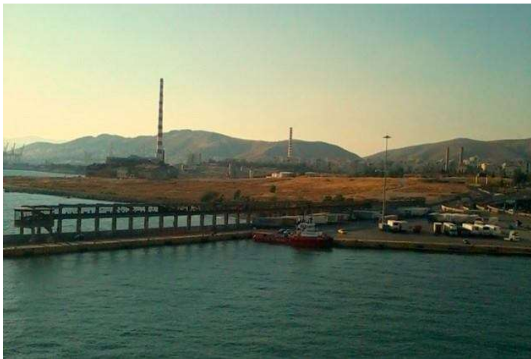
Εικόνα 36: Ο ταινιόδρομος του όρμου Κράκαρη Φωτογραφία από το αρχείο του Γραφείου Τύπου του Δήμου Κερατσινίου-Δραπετσώνας
