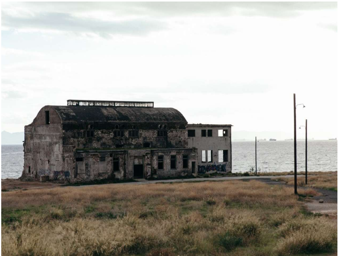
Εικόνα 31: Το κτίριο του ηλεκτρικού σταθμού από μακριά Φωτογραφία από το Διαδίκτυο
