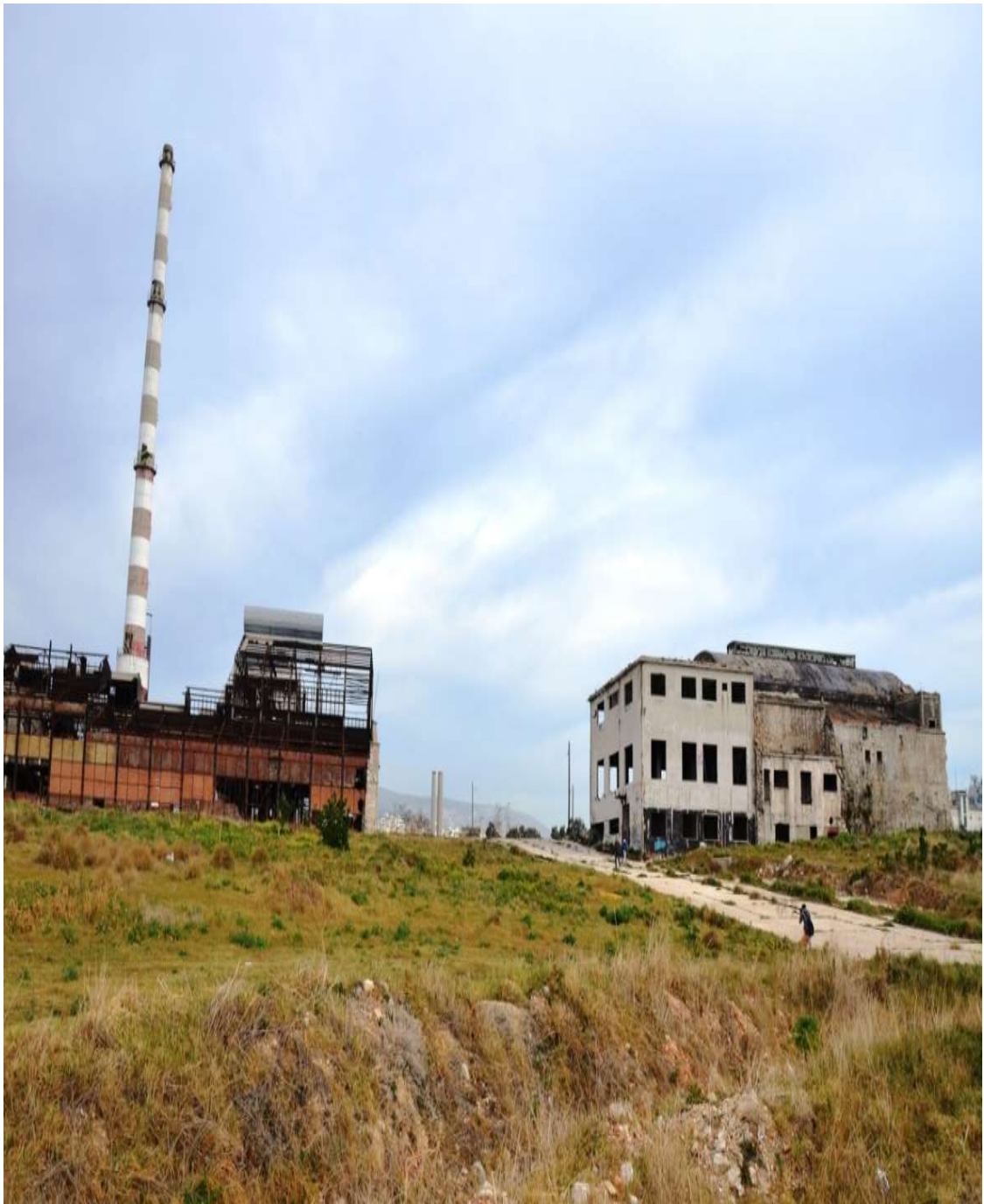
Εικόνα 29: Τα δύο εναπομείναντα κτίρια του εργοστασίου των Λιπασμάτων, το υαλουργείο και ο ηλεκτρικός σταθμός Φωτογραφία Γιώργου Μακρίδη
