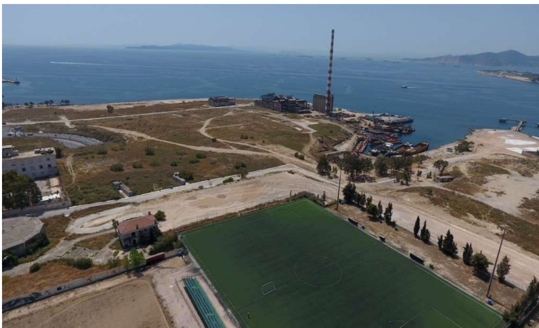
Εικόνα 43: Πανοραμική άποψη του υπό διαμόρφωση χώρου Φωτογραφία από Drone
