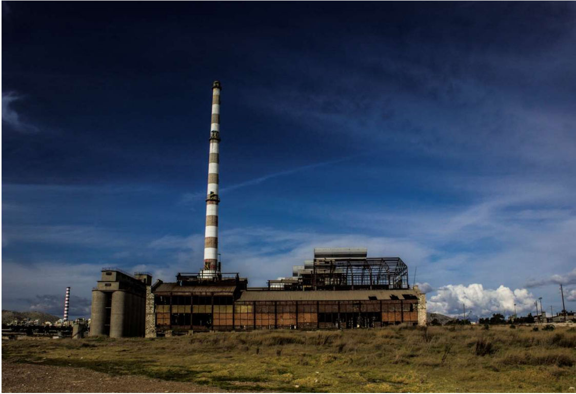
Εικόνα 24: Μέρος από τα εναπομείναντα κτίρια του εργοστασίου των Λιπασμάτων Φωτογραφία από το Διαδίκτυο
