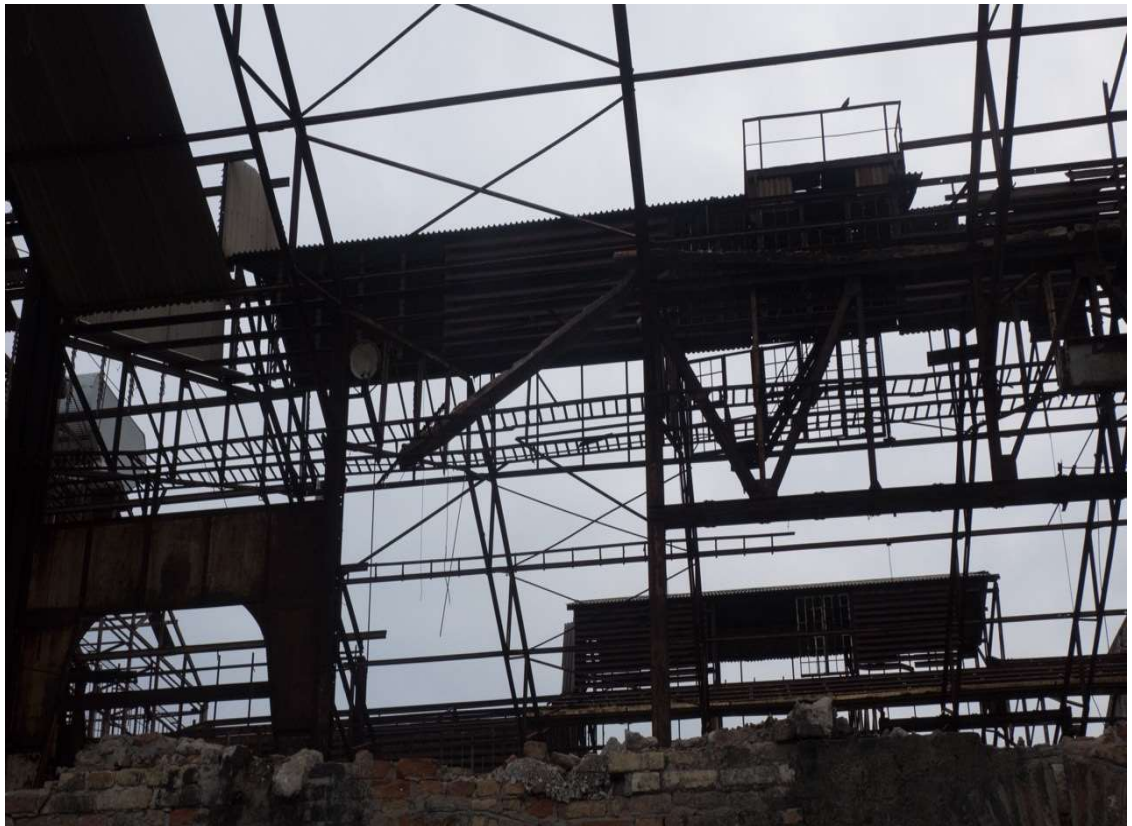
Εικόνα 38β: Απομεινάρια κτιριακών εγκαταστάσεων Φωτογραφία Μπάμπη Χριστακόπουλου
