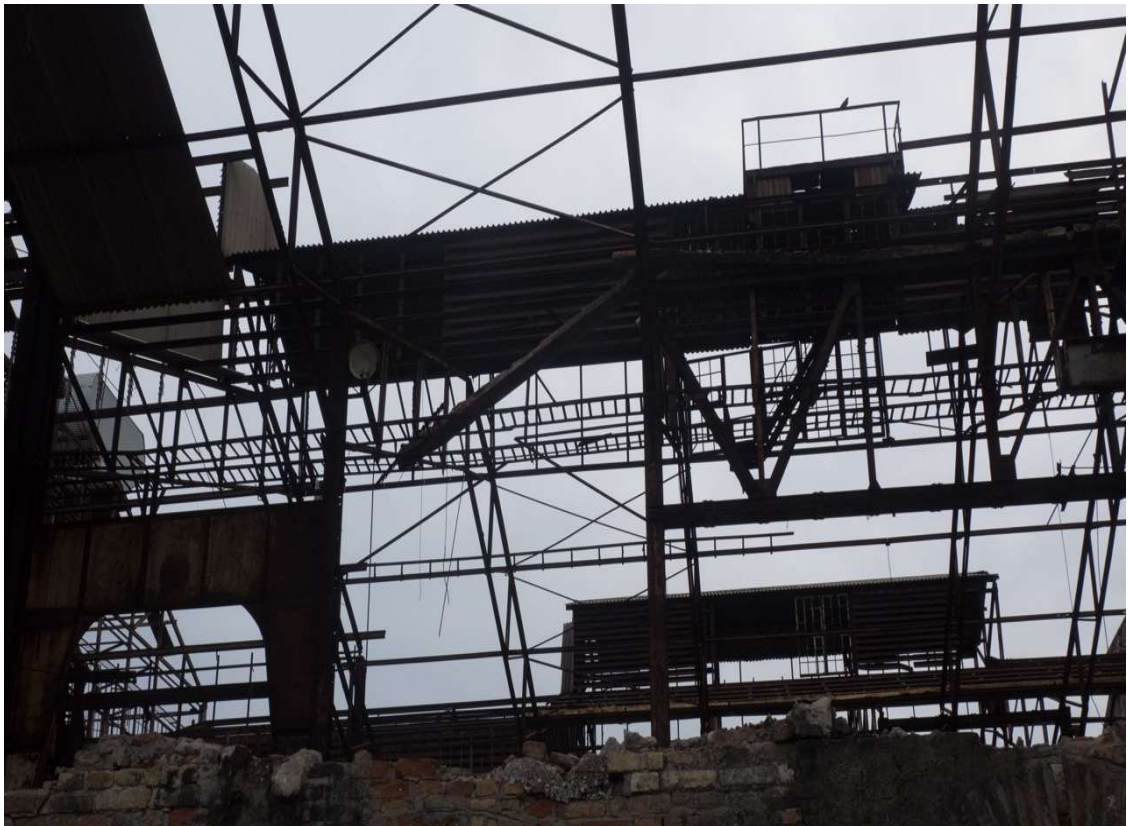
Εικόνα 38β: Απομεινάρια κτιριακών εγκαταστάσεων Φωτογραφία Μπάμπη Χριστακόπουλου
