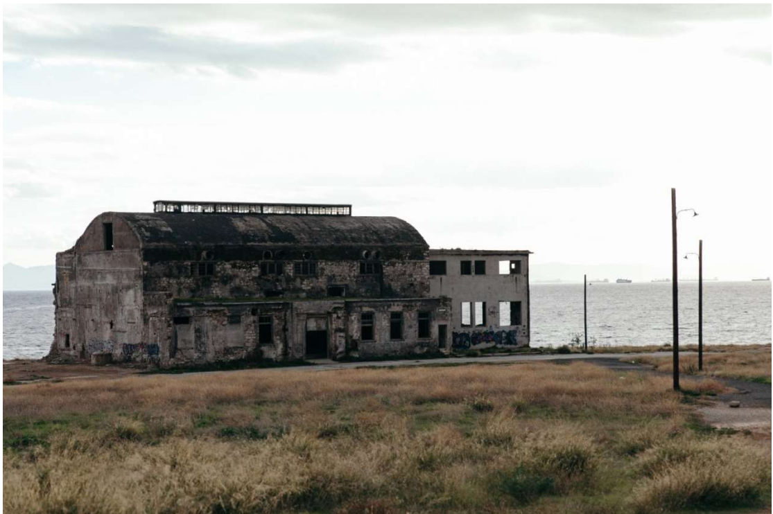
Εικόνα 31: Το κτίριο του ηλεκτρικού σταθμού από μακριά Φωτογραφία από το Διαδίκτυο
