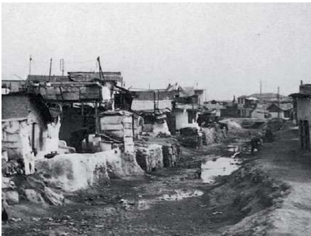
Εικόνα 7: Η εμφανής έλλειψη του αποχετευτικού δικτύου Φωτογραφία από το Ιστορικό Αρχείο του Δήμου Κερατσινίου - Δραπετσώνας
