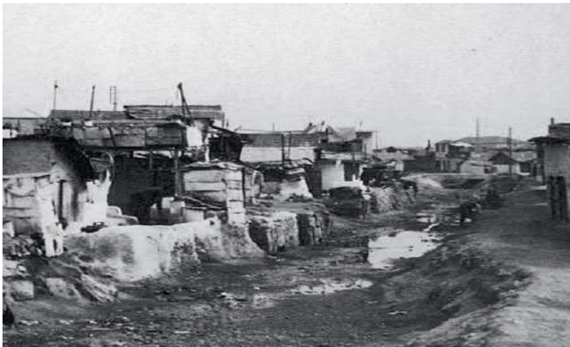
Εικόνα 7: Η εμφανής έλλειψη του αποχετευτικού δικτύου Φωτογραφία από το Ιστορικό Αρχείο του Δήμου Κερατσινίου – Δραπετσώνας
