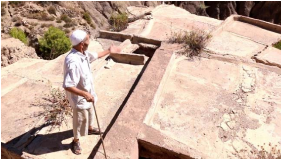
Εικόνες 192-195. Τσιμεντένια στέρνα με σκέπασμα από ξύλο (Beni-Ourtilane)
