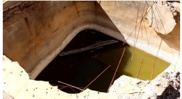
Εικόνες 192-195. Τσιμεντένια στέρνα με σκέπασμα από ξύλο (Beni-Ourtilane)
