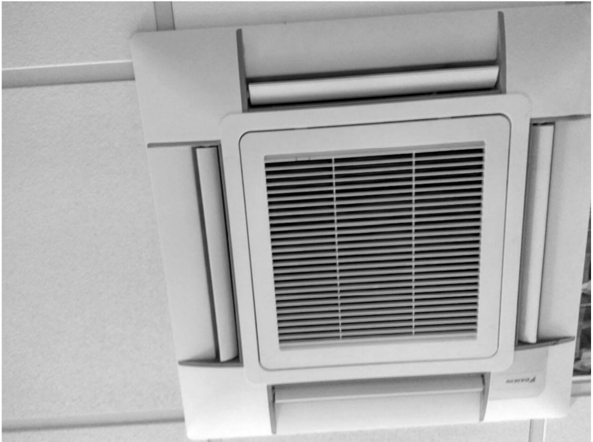
Εικόνα 4. Κλιματιστική μονάδα Daikin FXFQ125AVEB
