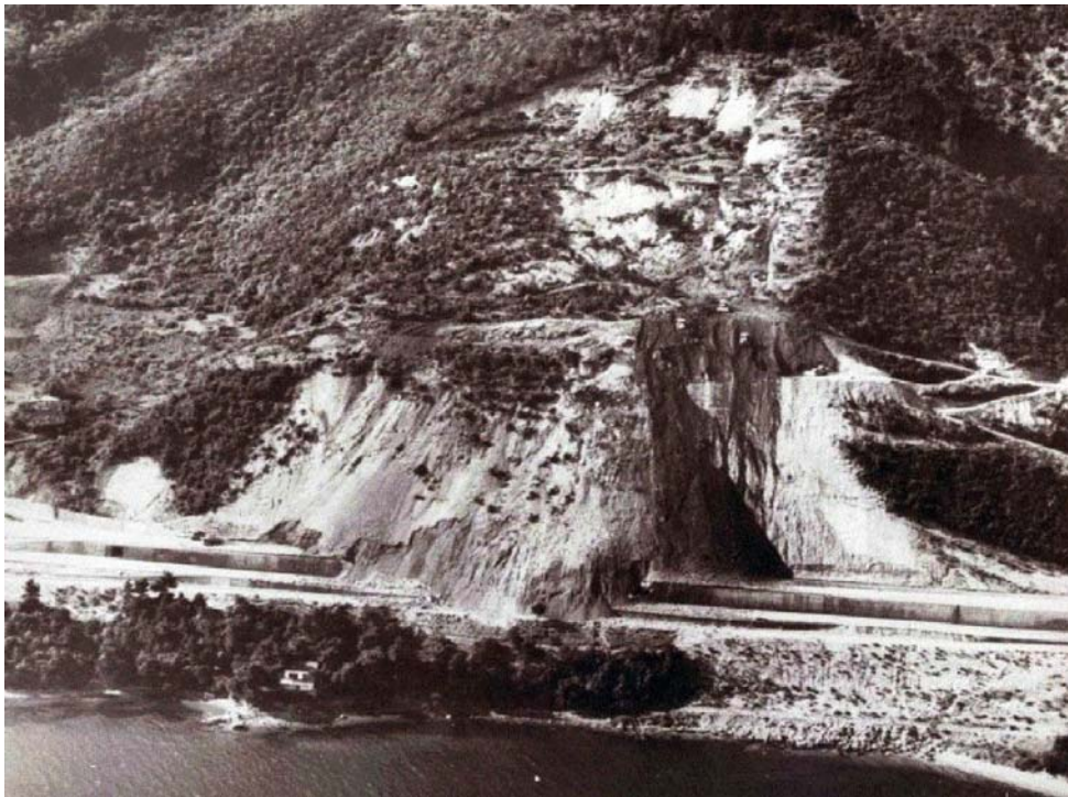
Εικόνα 2: Η κατολίσθηση Παναγοπούλας με την αποκοπή της εθνικής οδού Αθηνών – Πατρών σε φωτογραφική λήψη από ελικόπτερο (28 Απριλίου 1971). Πηγή: Αρχείο Γεωέρευνας Α.Ε.
