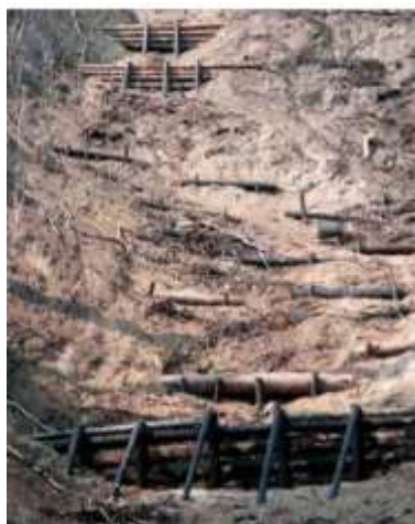
Εικόνα 2.8: «Κορμοφράγματα» για τη στερέωση του εδάφους σε παλαιά γεωλίσθηση που δημιουργήθηκε βαθμιαία μετά τη μεγάλη πυρκαγιά του 1932 (Μπαλούτσος και άλλοι, 2007).
