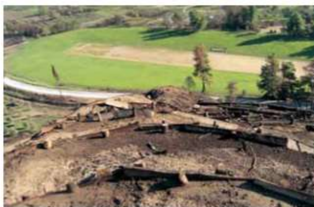
Εικόνα 2.7: Το διαβρωμένο από τις βροχές έδαφος στην κορυφή του Κρόνιου λόφου κρατήθηκε πίσω από τα κορμοδέματα. Στο βάθος το αρχαίο στάδιο της Ολυμπίας (Μπαλούτσος και άλλοι, 2007).
