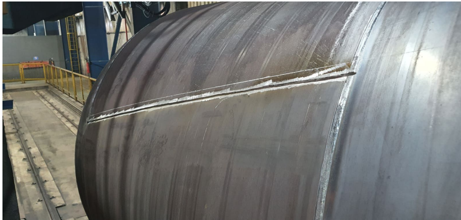
Εικόνα 38: Προετοιμασία για εγκάρσια συγκόλληση εξωτερικής επιφάνειας
