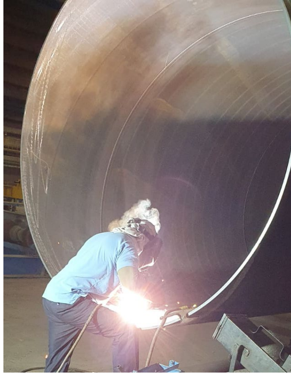
Εικόνα 23: Διαμορφωμένη σωλήνα σε διαδικασία χειροκίνητης επισκευής
