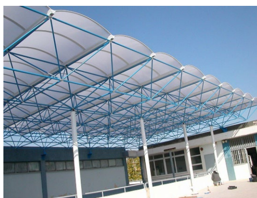
Εικόνα 5 : Κατασκευή από χωροδικτύωμα (Γκίνης,2023)
