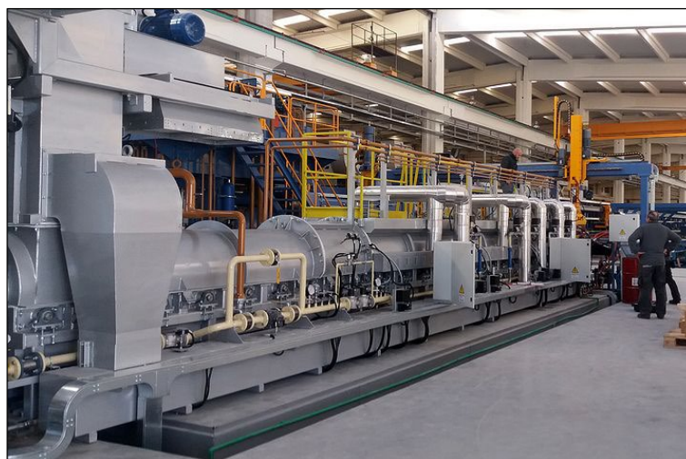
Σχήμα 4: Προθέρμανση μπιγιέτας αλουμινίου Πηγή: εξεταζόμενη βιομηχανία
