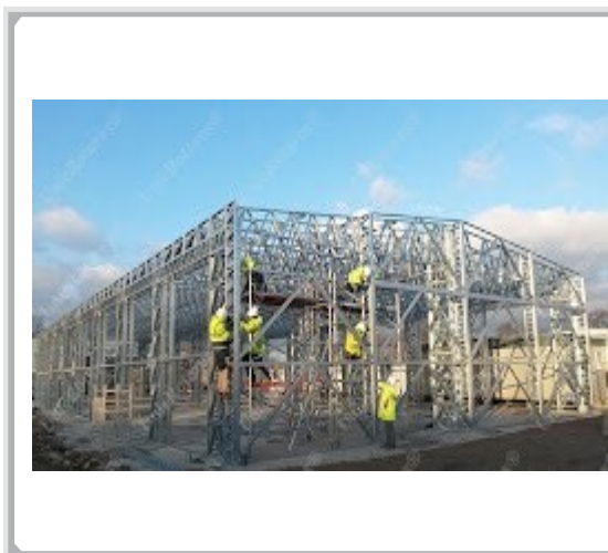
Κατασκευή Μεταλλικού Σκελετού (ελαφριού τύπου)
