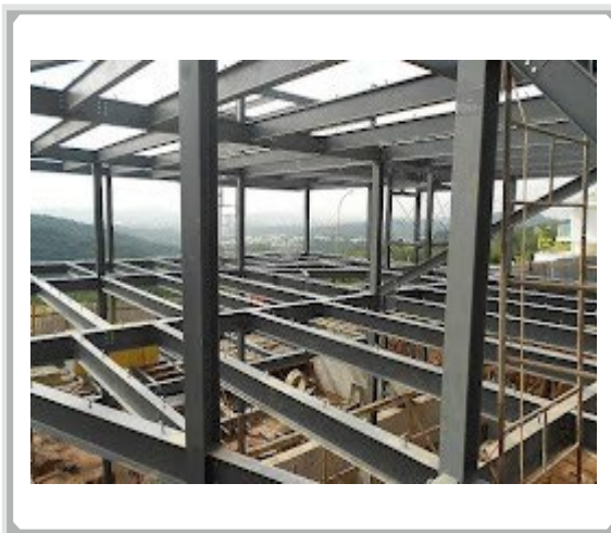
Κατασκευή Μεταλλικού Σκελετού (βαρετού τύπου)
