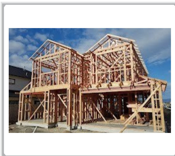
Κατασκευή Ξύλινου Σκελετού
