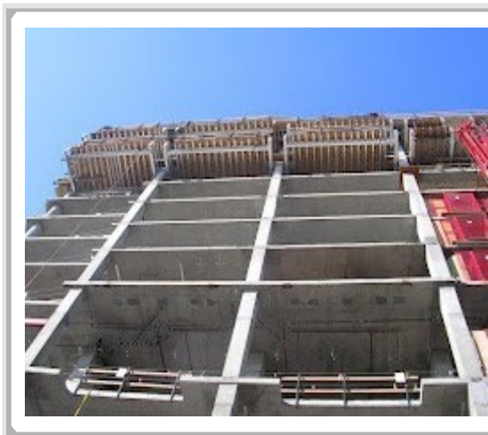
Κατασκευή Σκελετού από Οπλισμένο Σκυρόδεμα
