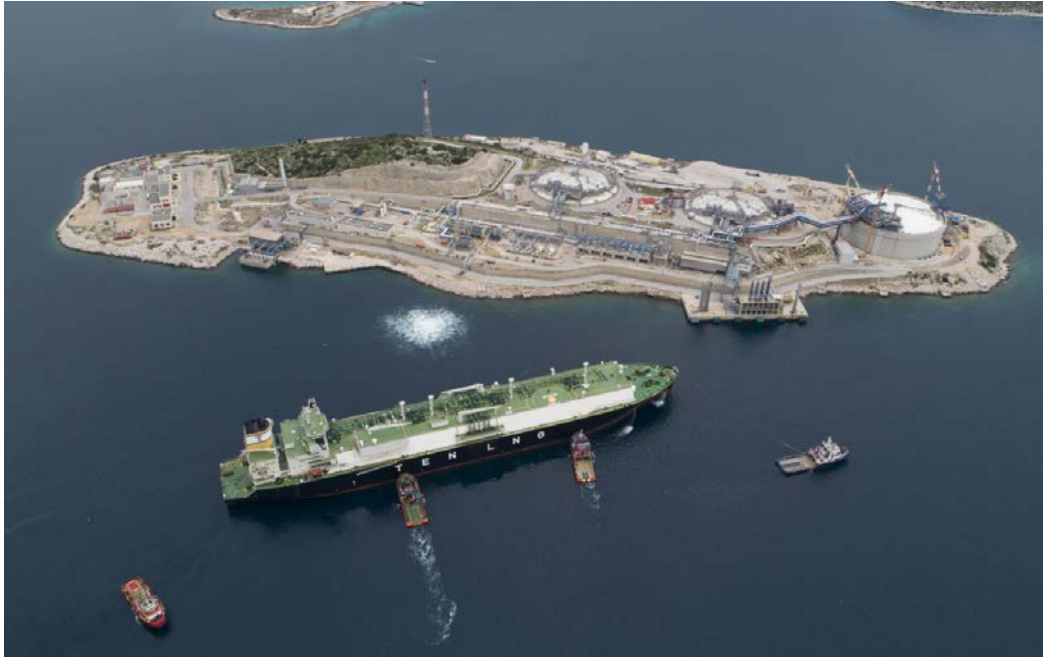
Εικόνα 4: Εγκαταστάσεις υγροποιημένου φυσικού αερίου στη Ρεβυθούσα στα Μέγαρα (Nautilia News, 2019).
