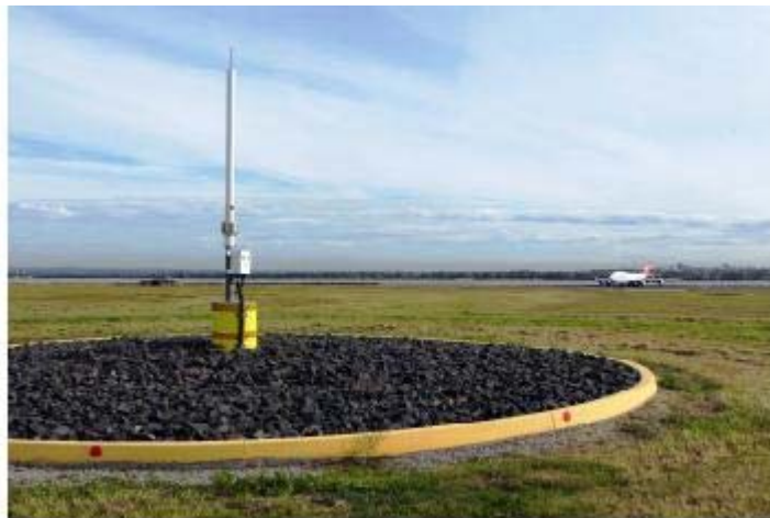
Σχήμα 7.6 Πρότυπη τοποθέτηση κεραίας RRA και περιοχή LOCA στο Αεροδρόμιο του Σύνδνεϋ [48]
