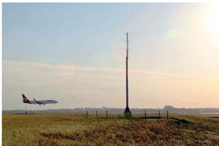
Σχήμα 7.10 Κεραία VDB στο αεροδρόμιο του Σύδνεϋ [48]
