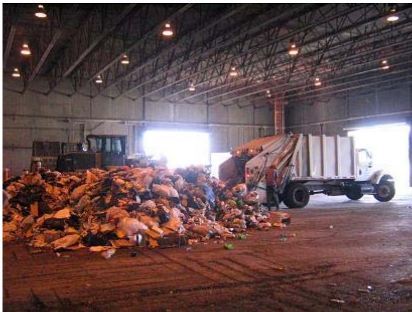
Εικόνα 3.4. Εκφόρτωση των οχημάτων συλλογής απορριμμάτων σε ευρύ δάπεδο (R.E. Beck Inc., 2010).
