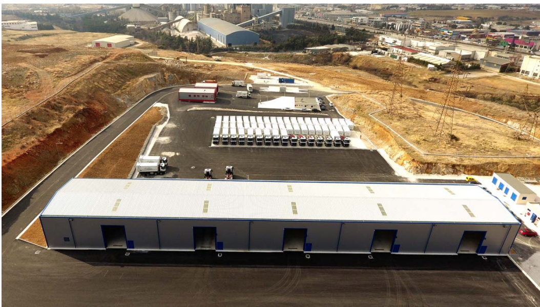
Εικόνα 4.1: Πάνω επίπεδο σταθμού μεταφόρτωσης απορριμμάτων Ευκαρπίας Θεσσαλονίκης όπου φαίνονται οι εισοδοί των απορριματοφόρων (ΦΟΔΣΑ, 2018)
