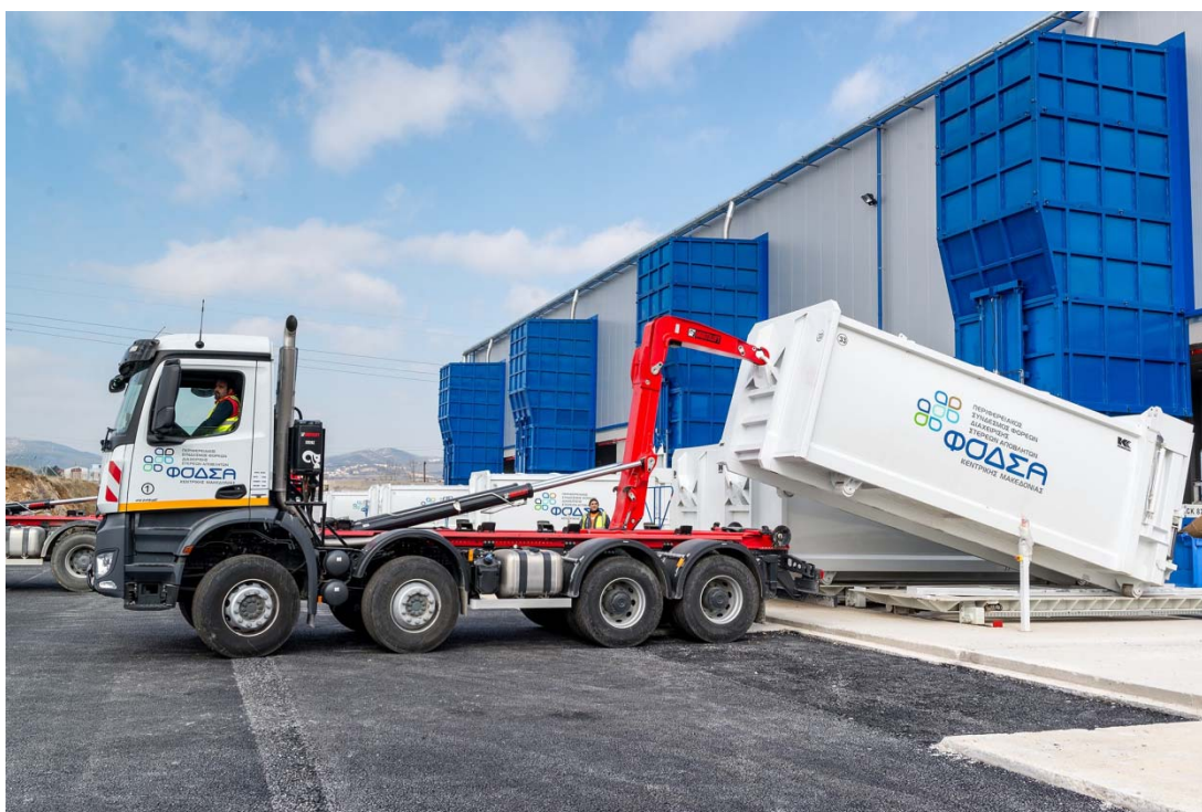
Εικόνα 4.2: Κάτω επίπεδο σταθμού μεταφόρτωσης απορριμμάτων Ευκαρπίας Θεσσαλονίκης όπου φαίνονται οι τέσσερις πρέσες συμπίεσης (ΦΟΔΣΑ, 2018)
