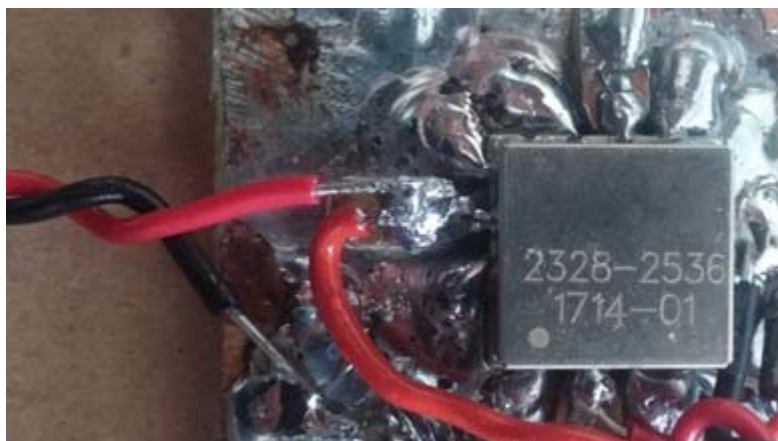
Εικόνα 8.19: Εφαρμογή καλωδίων για μεταφορά του V_{cc}
