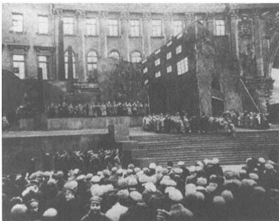
Φωτογραφία 2.6: Η Κόκκινη πλατφόρμα στην Κατάληψη των Χειμερινών Ανακτόρων στην Πετρούπολη, 1920.
