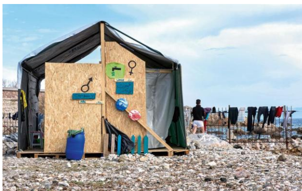
Εικόνα 7.2. Λέσβος 2016: Η παράγκα κατασκευασμένη από ΜΚΟ όπου στεγάζονται τουαλέτες, στον «καταυλισμό της πλαζ Τσαμάκια, λίγα μέτρα από το λιμάνι της Μυτιλήνης». Φωτ. του Ζωγράφου Δημ. Γέρου 127 (Καθημερινή 28.3.2016 )
