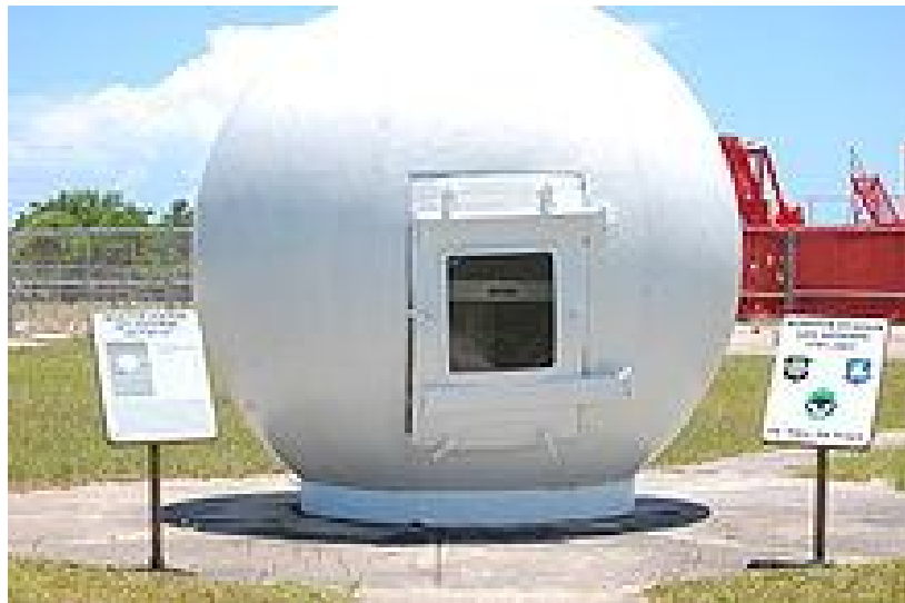
Εικόνα 1.6: Σταθμός Ελέγχου (Μουσείου Πυραύλων και Διαστήματος)
