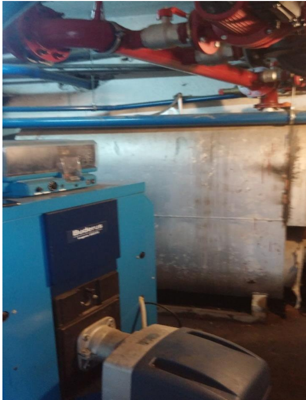
Εικόνα 9.3 : Κτήριο Β. Υφιστάμενη κατάσταση λεβητοστασίου (Πηγή : ΠΥΡΑΜΙΣ ΑΤΕ)
