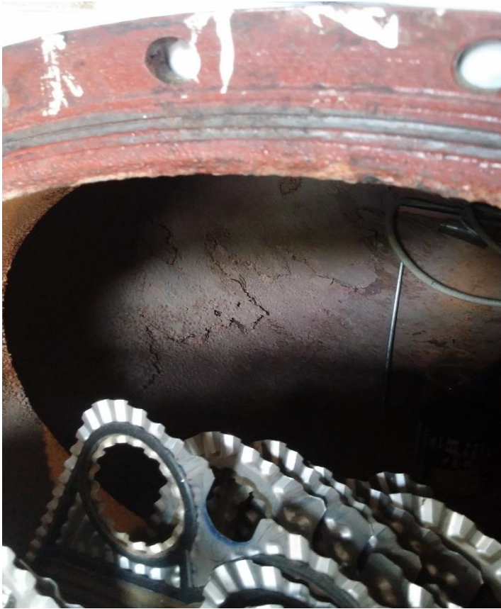
Εικόνα 9.5 : Κτήριο Β . Θερμοδοχείο που αποξηλώθηκε από την εγκατάσταση και πλακοειδής εναλλάκτης που αποξηλώθηκαν (Πηγή : ΠΥΡΑΜΙΣ ΑΤΕ)
