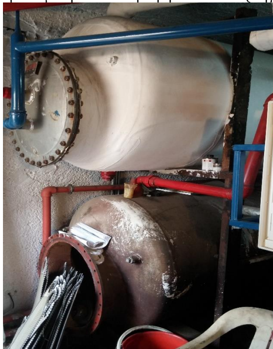
Εικόνα 9.4 : Κτήριο Β. Υφιστάμενη κατάσταση λεβητοστασίου Θερμοδοχεία που αποξηλώθηκαν (Πηγή : ΠΥΡΑΜΙΣ ΑΤΕ)
