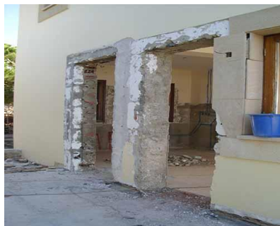
Εικόνα 2.7: Παράδειγμα επιλεκτικής κατεδάφισης
