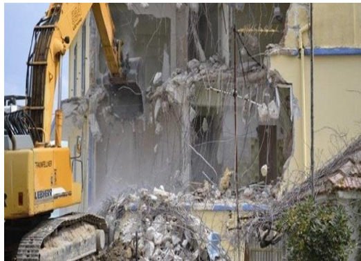
Εικόνα 2.1: Εργασίες κατεδάφισης οικοδομής
