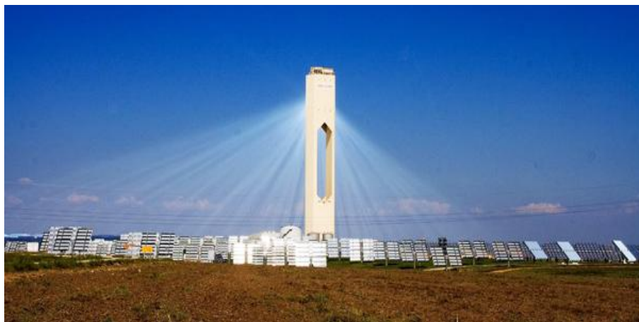
Εικόνα 22: Εγκατάσταση συγκεντρωτικής ηλιακής ενέργειας ισχύος 10MW στη Σεβίλλη της Ισπανίας
