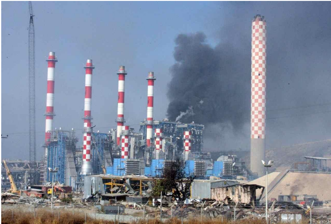
Εικόνα 4: Ο Ηλεκτροπαραγωγός Σταθμός Βασιλικού μετά την έκρηξη στις 11/7/2011
