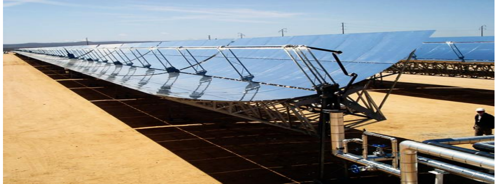
Εικόνα 23: Εγκατάσταση συγκεντρωτικής ηλιακής ακτινοβολίας στην οποία χρησιμοποιούνται παραβολικά κάτοπτρα.
