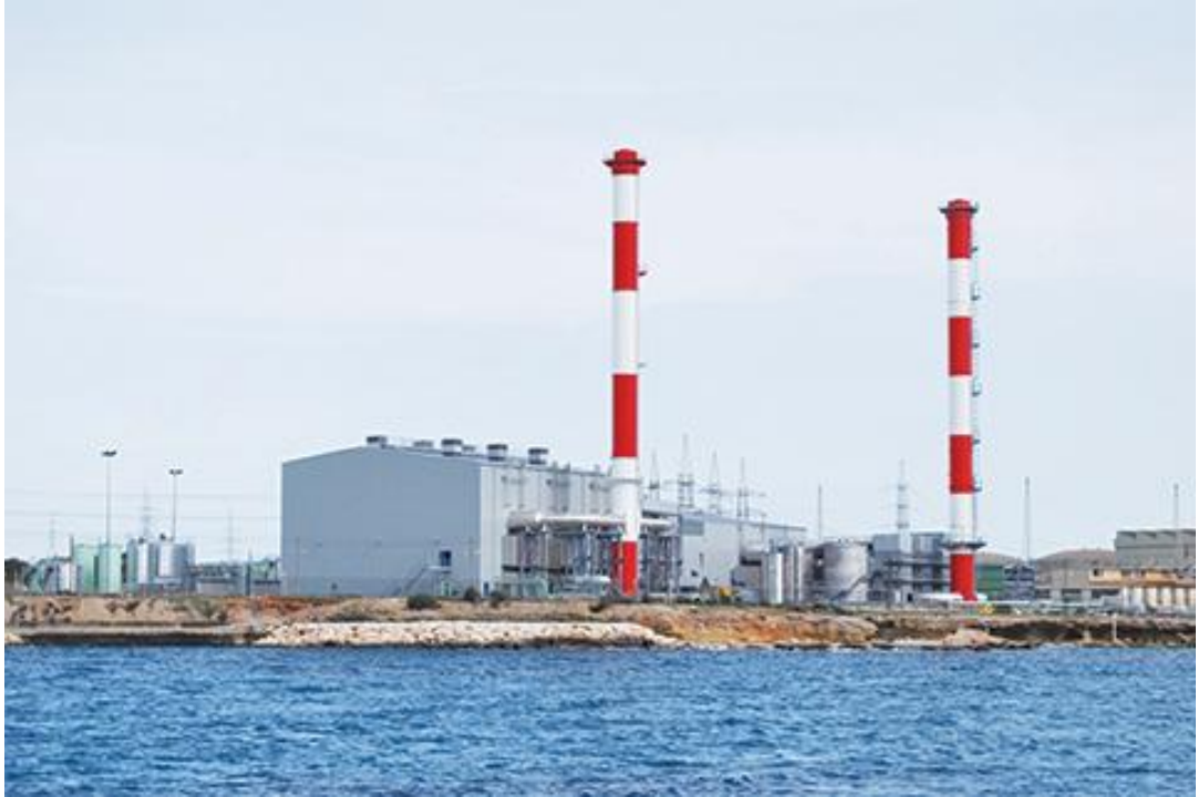
Εικόνα 14: Ηλεκτροπαραγωγός Σταθμός Δεκέλειας Β'
