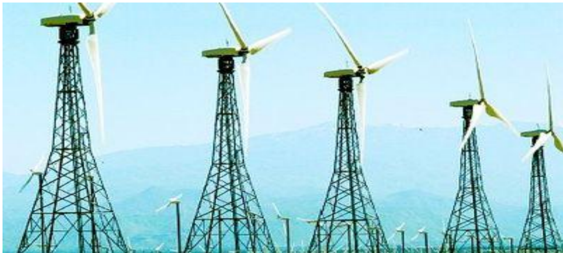
Εικόνα 1.4-3: Ανεμογεννήτριες με δικτυωτό πύργο (Πηγή: http://www.bdlive.co.za/ )
