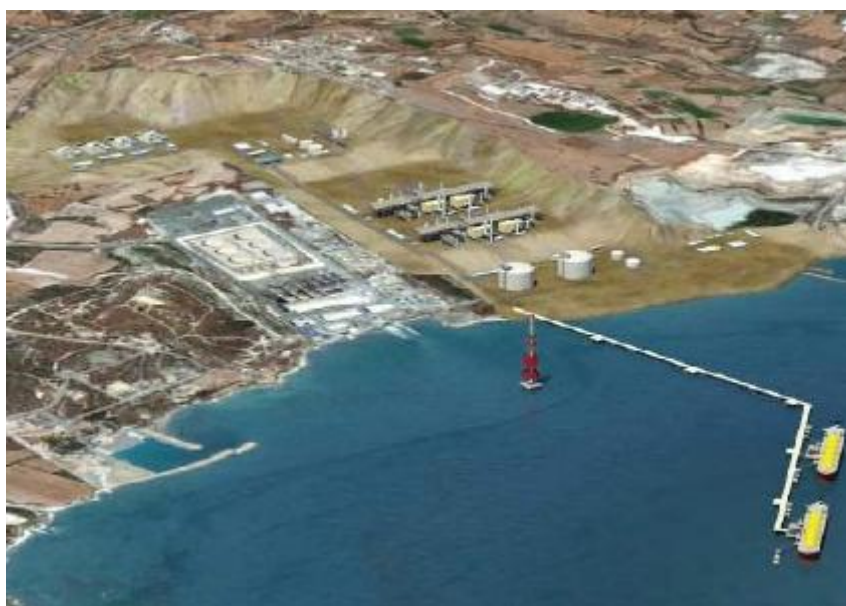
Εικόνα 10: Μονάδα παραγωγής Υ.Φ.Α. στην περιοχή Βασιλικός
