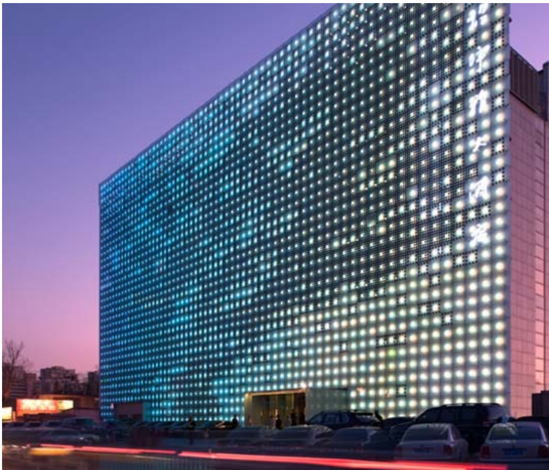
ZERO ENERGY MEDIA WALL στο Πεκίνο (είναι η μεγαλύτερη έγχρωμη οθόνη LED σε όλο τον κόσμο και το πρώτο φωτοβολταϊκό σύστημα ενσωματωμένο σε ένα γυάλινο τοίχο στην Κίνα. Το
